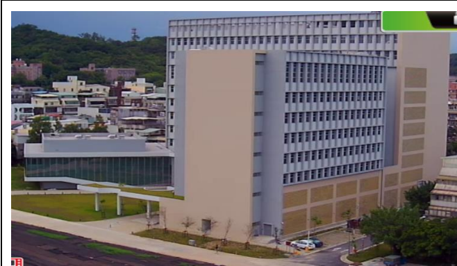
博愛校區生醫工程施工情況-1
