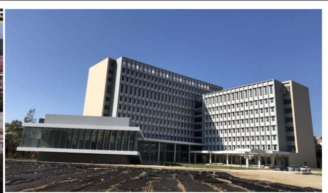
博愛校區生醫工程施工情況-2
