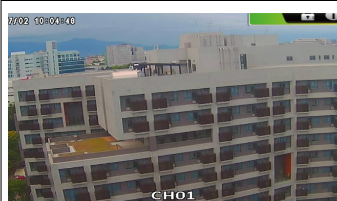
研究生第三宿舍興建工程施工情況-1
