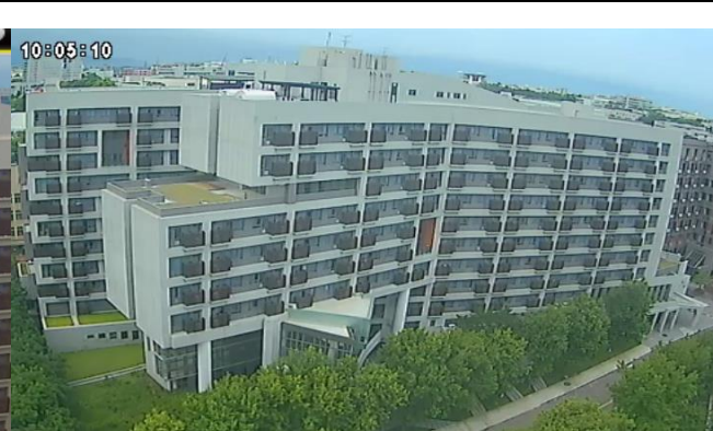
研究生第三宿舍興建工程施工情況-2
